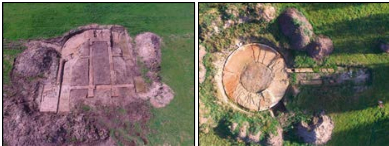
Linksonder de achterpoort of westpoort. Rechts is te zien dat een deel van de poort helemaal is weggebroken. Rechtsonder de noordwestelijke hoektoren (Foto's Stichting Kasteel van Wouw)
