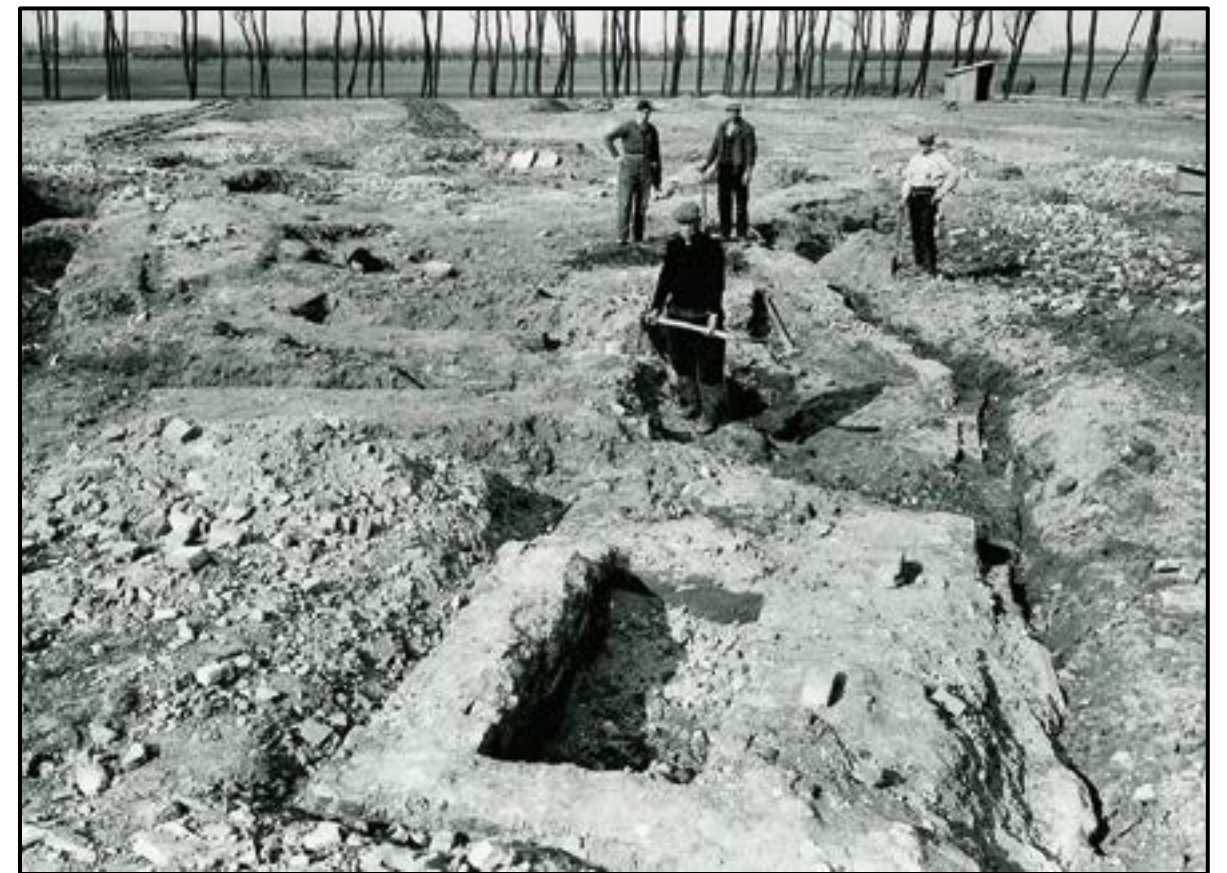
De oostelijke fundamenteën van de ronde burcht in 1934. De fotograaf stond in de ronde toren en keek naar het noorden. Met primitieve gereedschappen waren de arbeiders aan de slag. De man op de achterste rij uiterst links is opzichter H. Regtop uit Sprundel (Archief RCE Amersfoort objectnummer 14.014)
