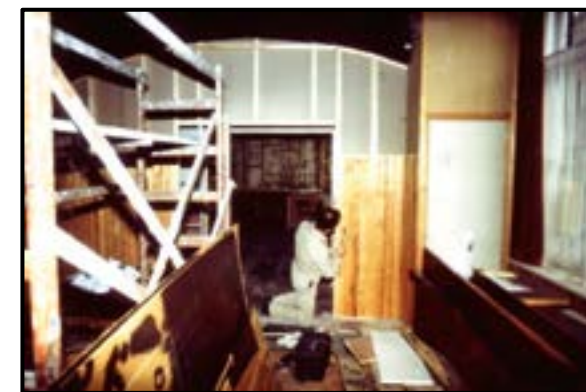
1988. Jan Aanraad bezig met de lambrisering van de wand van de Stijlkamer
