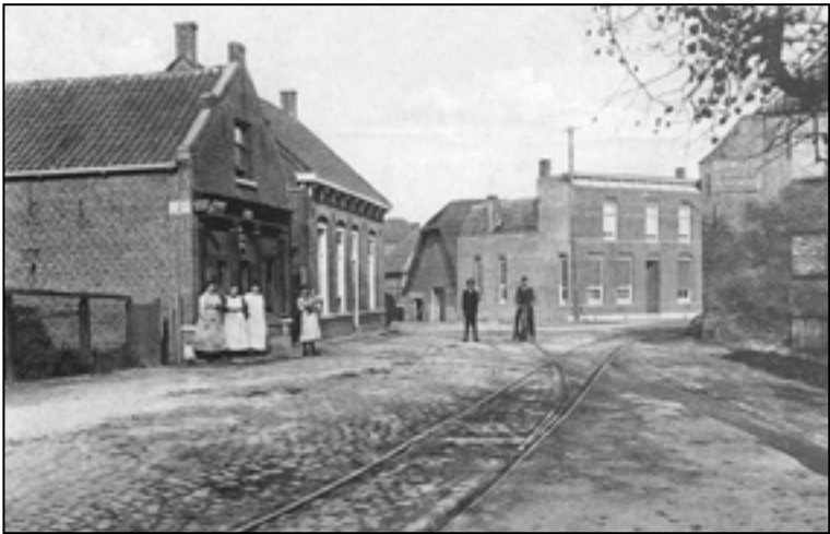
Midden: Bijna alle bietentrans naar de Coöperatieve Beetwortelsuikerfabriek 'Dinteloord' reden vanuit Oud Gastel rechtstreeks naar de fabriek. Slechts een enkeling werd tijdelijk gestald in de Brugstraat. Zodra er plaats was, kwam de tram links uit de Brugstraat en draaide iets verderop de Noordzeedijk op.
