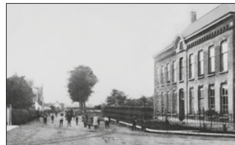
Rechts staat de pastorie van de R.K. Kerk. Duidelijk is te zien dat het van links komende spoor (uit 1914) in een boog eerst het spoor naar en van Oudenbosch (uit 1892) kruist en dan naar rechts via een stukje van de voormalige tuin gaat. Daarvoor moest een stuk muur wijken en werd het hek deels verplaatst en aangepast. Ansichtkaart uit circa 1915, collectie heemkundekring Het Land van Gastel.
