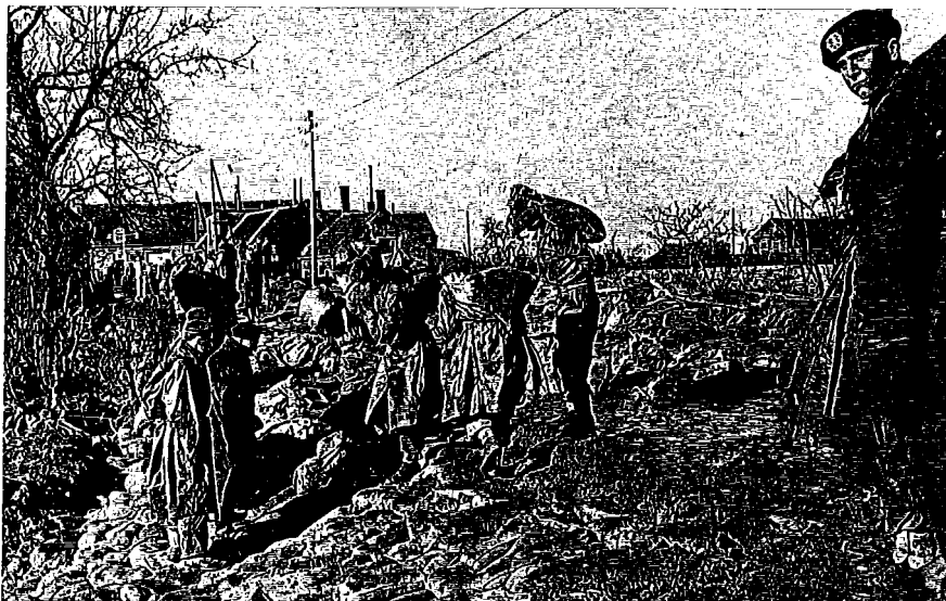
Dijkherstel d.m.v. zandzakken
