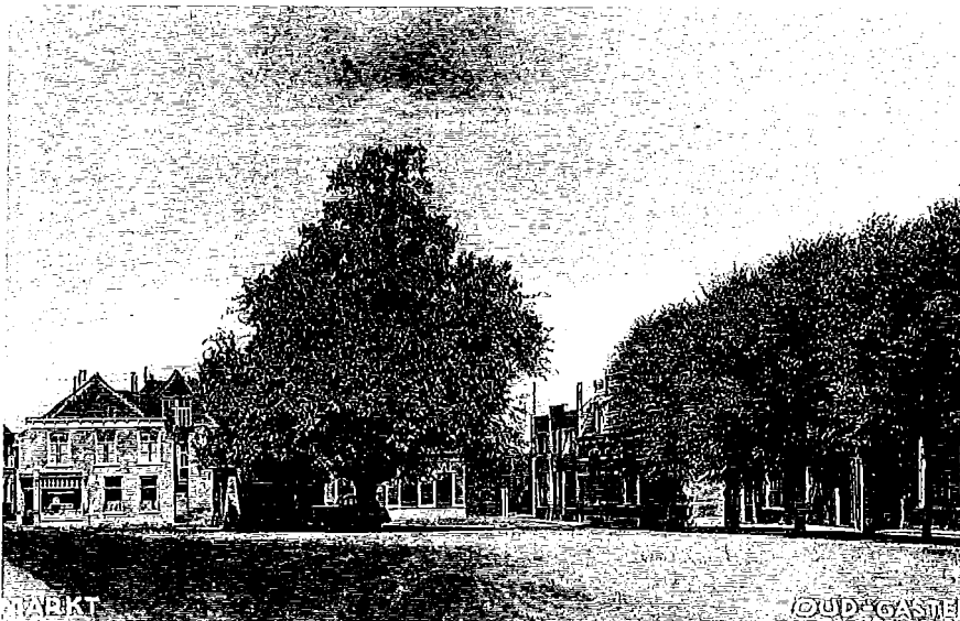
De Markt ca. 1952 Onder de lindeboom het transformatorhuis- je dat in 1953 werd afgebroken. Rechts is nog een ge- deelte van het Hof zichtbaar.
