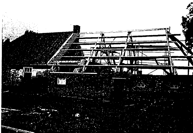
Oude Steenstraat 36a met kapconstructie van herbouwde landbouw- schuur in 1994
