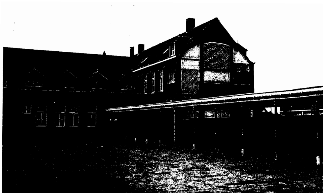
Deze foto is genomen vanaf het binnenplein van de St. Joannesschool. Dit was tot 1955 het Internaat. Een gedeelte is in 1983 gesloopt en de rest in 1984.
