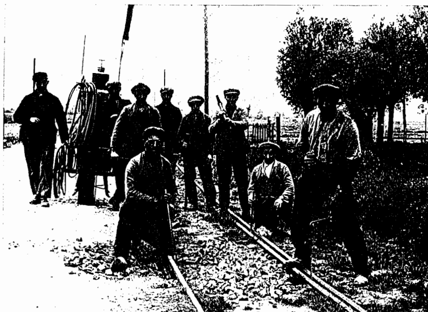
ONDERHOUDSWERKZAAMHEDEN AAN DE TRAMLIJN TE OUD GASTEL
