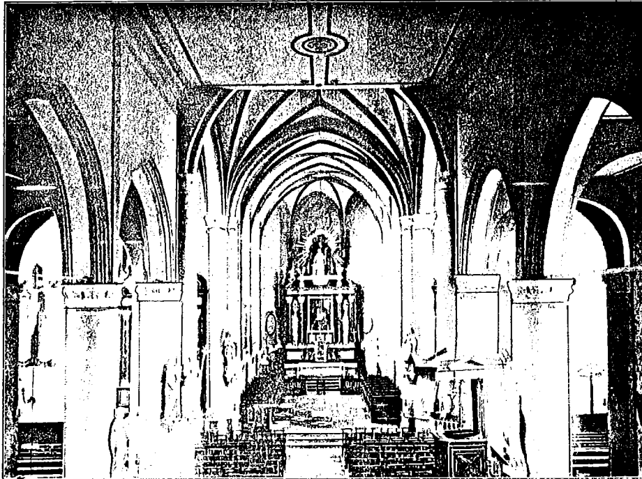
AFB 4, DE AFGEBROKEN KERK TE OUD-GASTEL. Binnenzijde.
